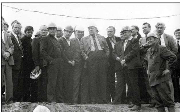
Министр среднего машиностроения СССР Е. П. Славский на строительстве здания ДОЛ. Июнь, 1982 г.
